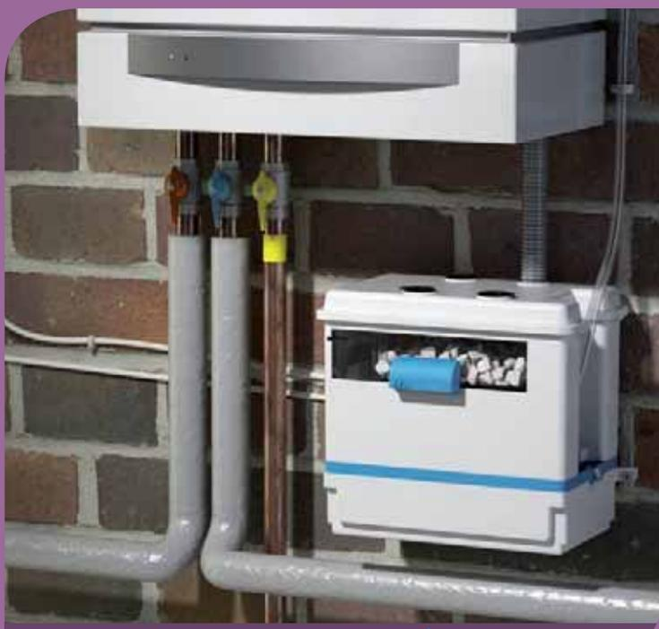
Refoulements vertical et horizontal : ↑ 4,5 m → 50 m
