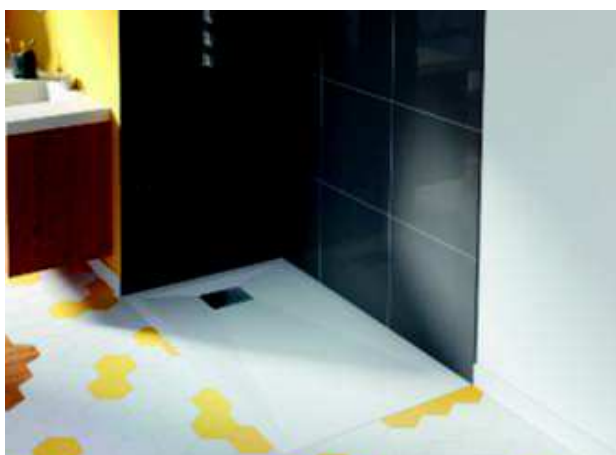
Kinesurf (4 cm) - pose avec décaissement total
